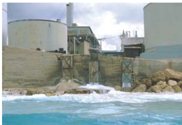
Photo 2.3: Installation industrielle au nord de Batroun dans le nord du Liban. Acide sulfurique déversé directement en mer près de l'installation de phosphate.
