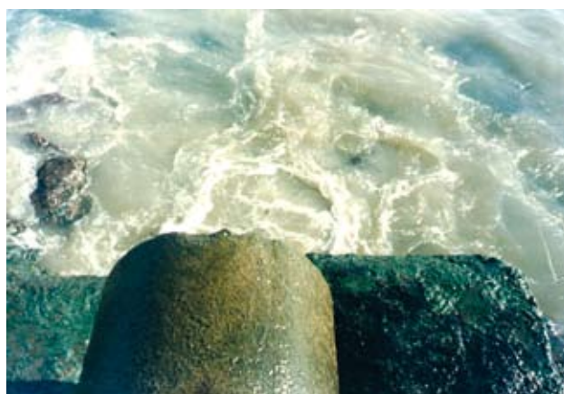
Photo 3.1: Eaux usées rejetées directement dans la mer (Alger).
